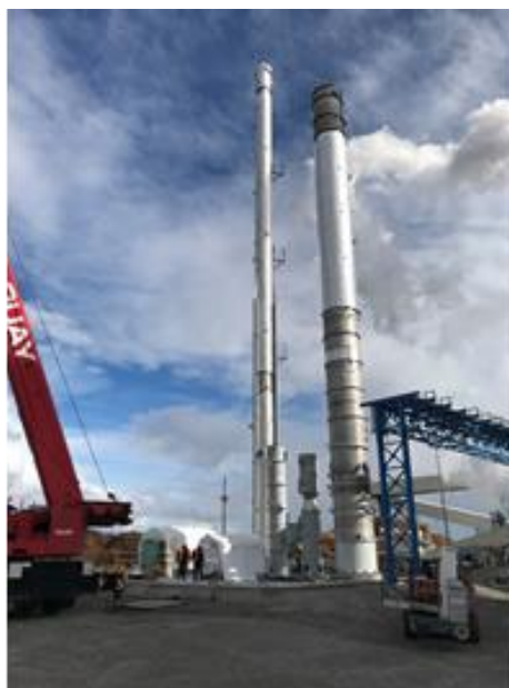
Unité de capture de 30 tonnes par jour de CO 2 Solutions en construction à Saint-Félicien
